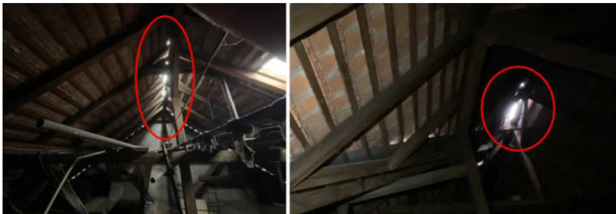
chybějící hřebenáče v objektu A, více v posudku [2]
